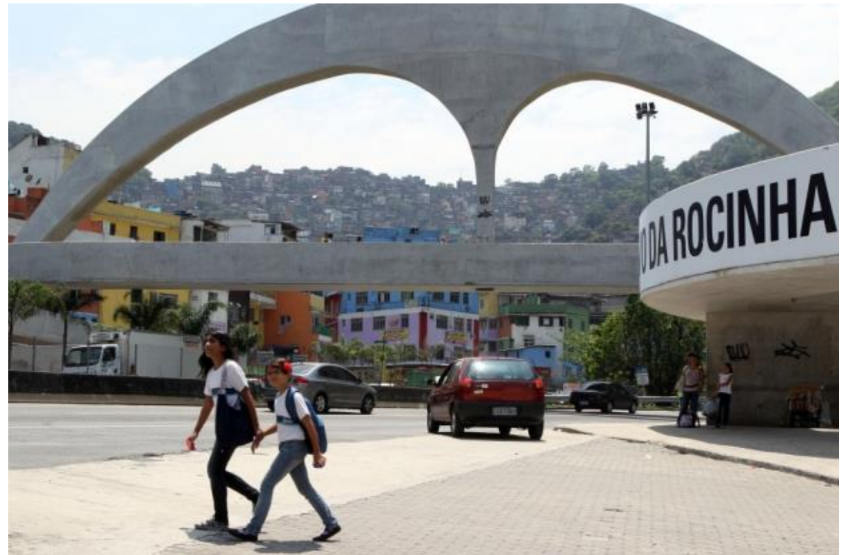
PASSARELA DA ROCINHA, R$ 15.000.000,00 - 5,4% do total do PAC na favela. SANEAMENTO NA ROCINHA, R$ 5.281.805,15 - 1,9% do total do PAC na favela. Foto: WILTON JUNIOR/AGENCIA ESTADO/AE
