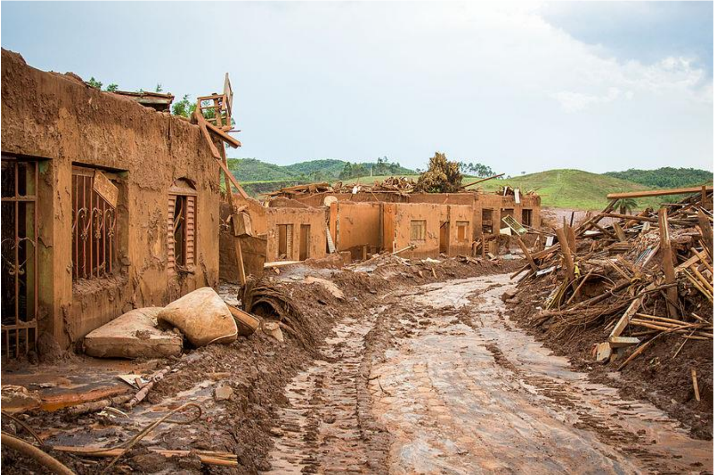
Rua de Bento Rodrigues após rompimento da barragem em Mariana (Imagem: Reprodução Wikimedia Commons)
